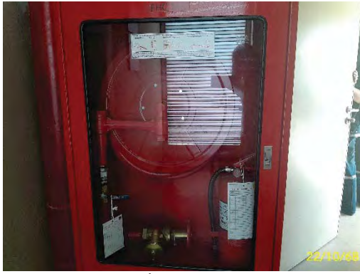
ตู้เก็บสารชนิดน้ำดับเพลิงและอุปกรณ์
